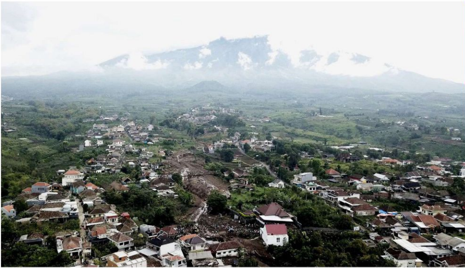
Lokasi banjir bandang di Desa Bulukerto, Kecamatan Bumiagi, Kota Batu, Jawa Timur, Jumat (5/11/2021). Banjir bandang yang terjadi pada Kamis (4/5) pukul 15.00 itu mengakibatkan 11 rumah rusak dan 23 rumah terendam lumpur.
